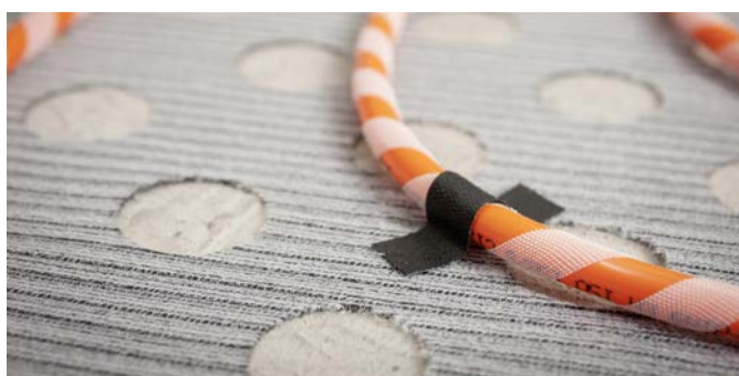
Img. 3-2 Exemplu de aplicație bandă fixare RAUTHERM SPEED
